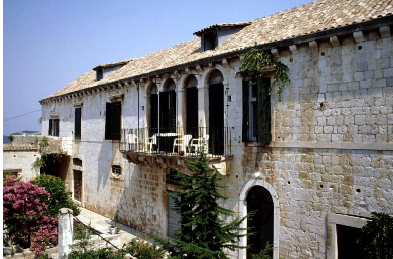
Vis, Jakinovi dvori, kvadrifora na pročelju
