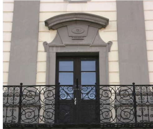
Balkonska vrata na pročelju
